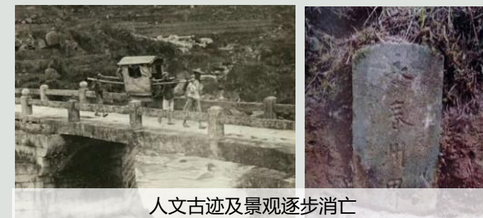
废弃、破损严重
